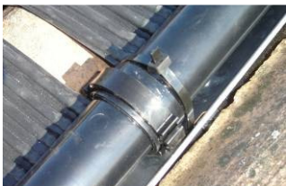
Bevestiging m.b.v. aluminium profielen
