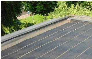
Bevestiging met een lijmpasta
